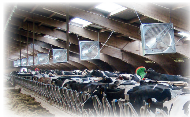
Beispiel aus der Praxis: Ventilatoren oberhalb von Liegeboxen
